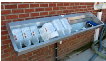
▲ Exemples de systèmes de séchage des bidons permettant de récolter les égouttures. ▲
