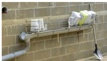
▲ Exemples de systèmes de séchage des bidons permettant de récolter les égouttures. ▲
