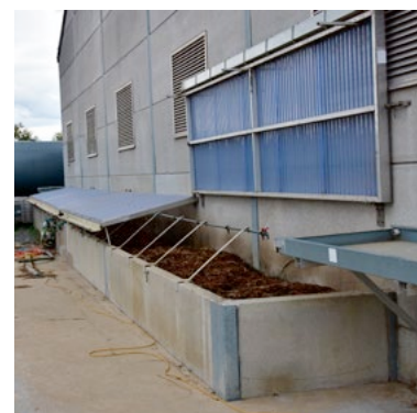
▲ Toiture sur charnières
