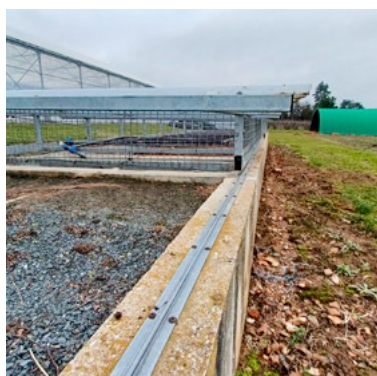
▲ Toiture sur rail
