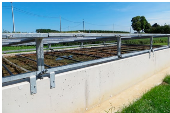
▲ Bac en béton armé coulé sur place
