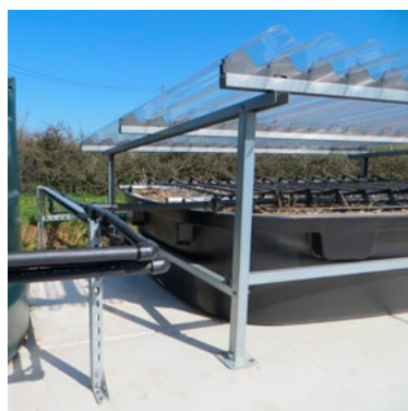
▲ Toiture boulonnée sur un cadre métallique
