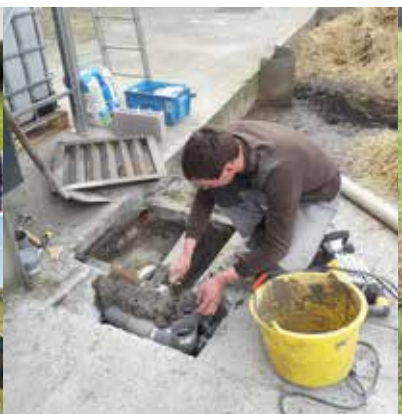
> Montage d'un biofiltre par l'équipe du centre d'action de Gembloux.
